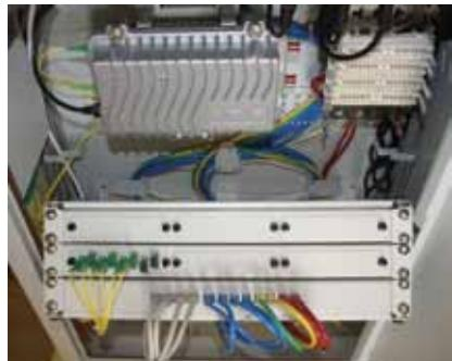
— Предусмотрена установка и возможна поставка Оптического узла доступа серии ONT-F20-116-220-D20-C, предназначенного для преобразования оптических аналоговых и цифровых сигналов кабельного телевидения в радиочастотные телевизионные сигналы с последующим их усилением до уровня, достаточного для распределения сигнала на 150-200 абонентских отводов.
